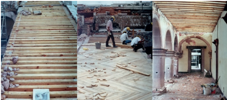
Imágenes 128 129 y 130. Colocación de vigería de madera y duela en azotea de la planta alta. Fuente: AJLGR.
