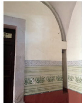
Imagen 2. Evidencias obtenidas durante el proceso de restauración del año 2000 de la existencia del portal de peregrinos, cuyos arcos exteriores e interiores permanecieron abiertos hasta la primera mitad del siglo XIX, como lo demuestra la ornamentación pictórica localizada en los anchos del muro con los que fueron tapiados, conformando diferentes salones. Fuente: AJLGR.
