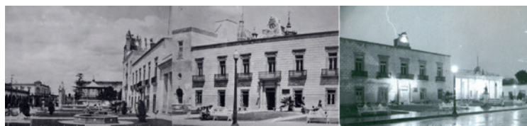
Imágenes 81, 82 y 83. Fotografías de la Escuela Preparatoria. Fuente: AHEA.
