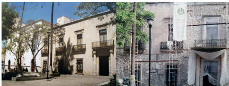
Imágenes 117 y 118. Fachada antes de la intervención y durante el proceso. Fuente: AJLGR.
