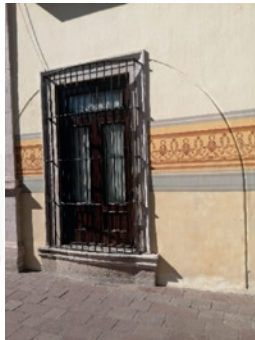
Imagen 2. Evidencias obtenidas durante el proceso de restauración del año 2000 de la existencia del portal de peregrinos, cuyos arcos exteriores e interiores permanecieron abiertos hasta la primera mitad del siglo XIX, como lo demuestra la ornamentación pictórica localizada en los anchos del muro con los que fueron tapiados, conformando diferentes salones. Fuente: AJLGR.
