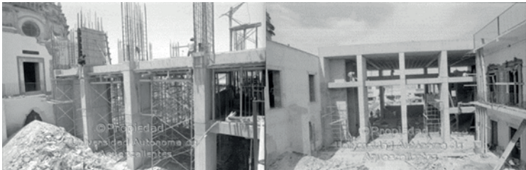
Imágenes 101 y 102. Construcción del Edificio Polivalente. Fuente: Fototeca UAA.
