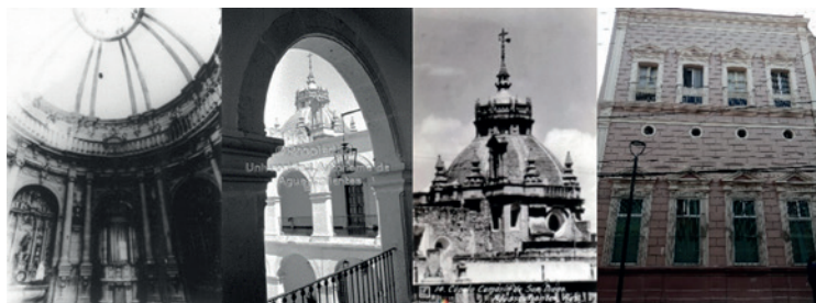
Imágenes 45, 46, 47 y 48. Interior y exterior del Camarín de la Virgen y anexo conventual al templo de la Tercera Orden. Fuente: Archivo UAA y AJLGR.
