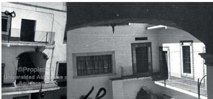
Imágenes 91 y 92. Segundo patio edificio “J. Gómez Portugal” a finales de los 60. Fuente: Fototeca UAA.
