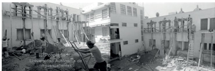
Imágenes 106 y 107. Modificación de la planta alta del edificio “J. Gómez Portugal” hacia el patio principal del edificio “19 de Junio”.
