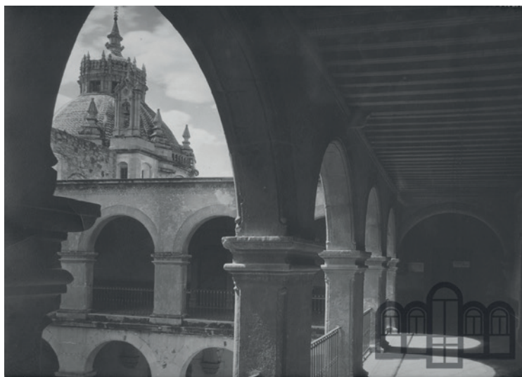
Imagen 84. Claustro del Instituto de Ciencias con su viguería original antes de la sustitución de la misma por rieles y bóveda de ladrillo. Fuente: AHEA.
